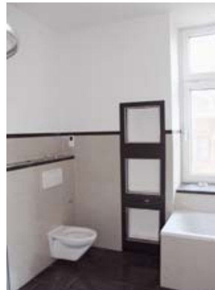
So sehen die fertigen Wandflächen in der Rödiger Straße 120 in Wuppertal nach der Sanierung aus.
