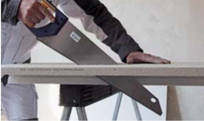
Die Klimaplatte wird mit dem Fuchsschwanz zugeschnitten.
