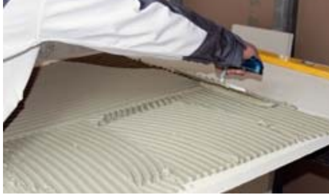
Auftragen des Systemklebers mit der Zahnpachtel.
