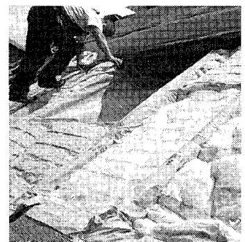
Sanierungsfall Dach: Unter die „Konterlattung mit diffusionsoffener Unterspannbahn“ (Foto links) kam ebenfalls eine komplett neue Dämmschicht. Fotos: privat
